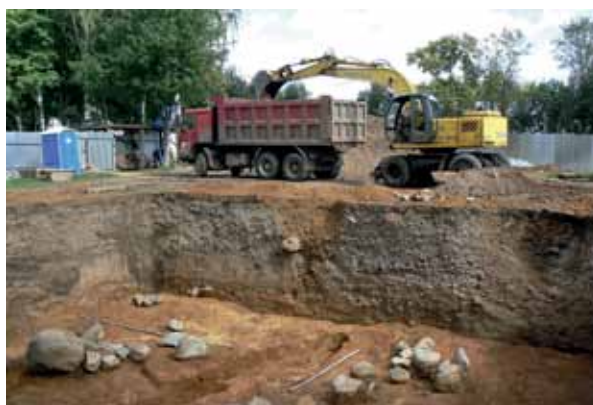
Рис. 21. Площадки исследования: рабочий процесс (отгрузка и вывоз отработанного грунта (северо-восточная часть площадки исследования). Общий вид с юго-запада. Фото
