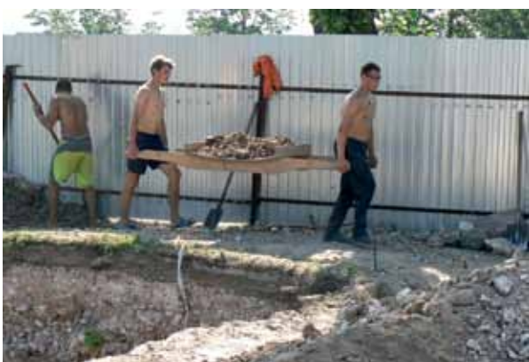
Рис. 19. Участок I: рабочий процесс (перемещение отработанного грунта к месту складирования (северо-восточная часть площадки исследования). Общий вид с востоко-северо-востока. Фото
