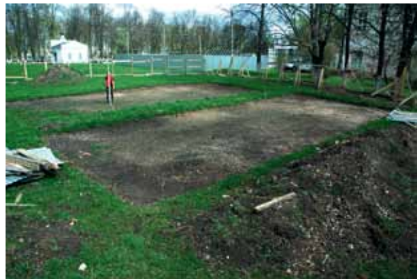
Рис. 6. Участок местонахождения Успенского собора весной 2016 г.: в восточной половине – огороженный участок земляных работ в 2015 г. С.И. Алексеевым. Общий вид с юго-запада. Фото
