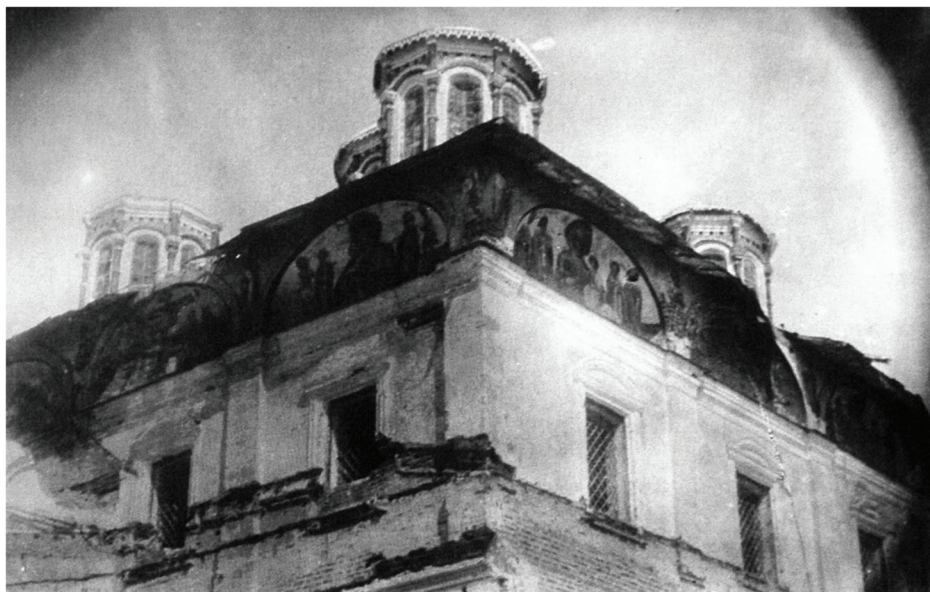
Рис. 3. Фото ЮЗ части четверика в процессе разборки в 1934 г. ГНИМА. VIII-27646
