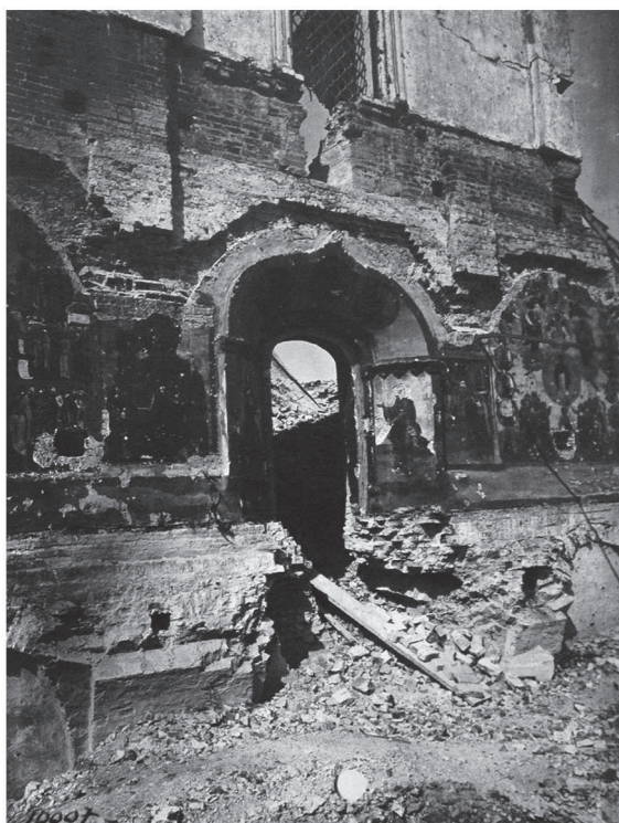
Рис. 7. Фото северной стенки четверика после разрушения придела вмч. Федора Стратилата в 1934 г. ГНИМА. V-5113
