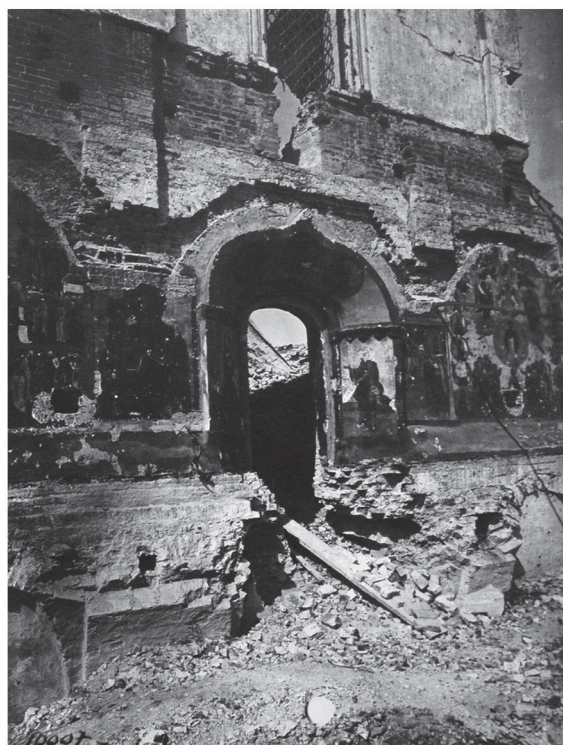
Рис. 7. Фото северной стенки четверика после разрушения придела вмч. Федора Стратилата в 1934 г. ГНИМА. V-5113
