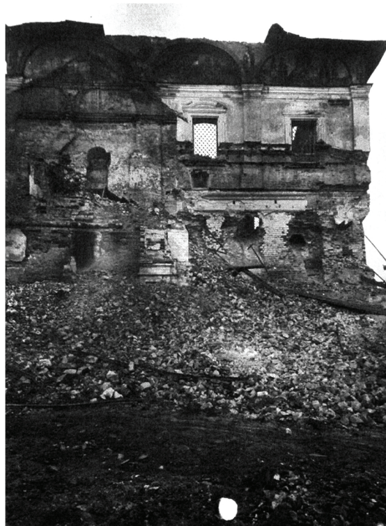
Рис. 5. Фото северной стенки четверика после разрушения придела вмч. Федора Стратилата в 1934 г. ГНИМА. V-5113
