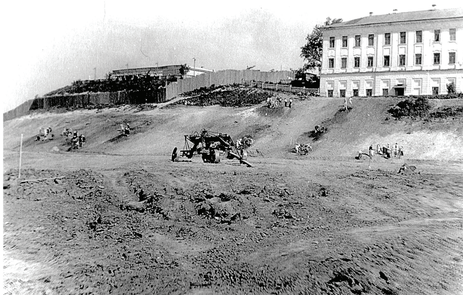
Рис. 2. Фото рабочего процесса разбора костромского кремля (1934 г.). Общий вид площадки с ЮВ, от р. Волги
